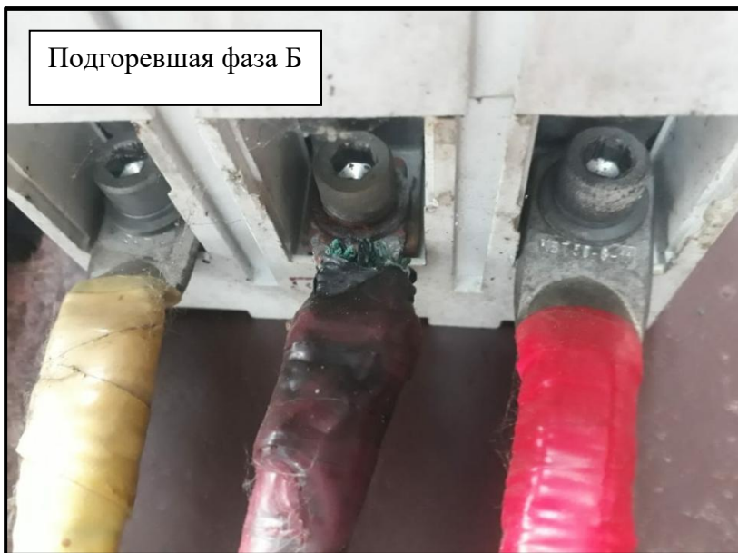
Наконечники не соответствуют сечению привода
